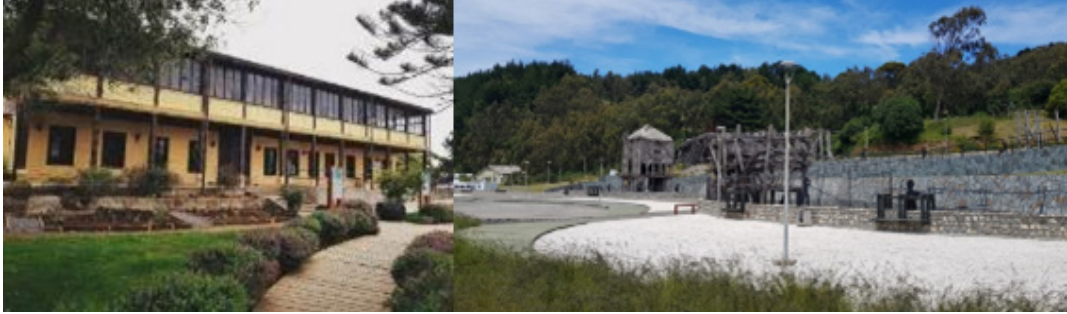
Figura 8 Edificaciones singulares recicladas para usos culturales.
