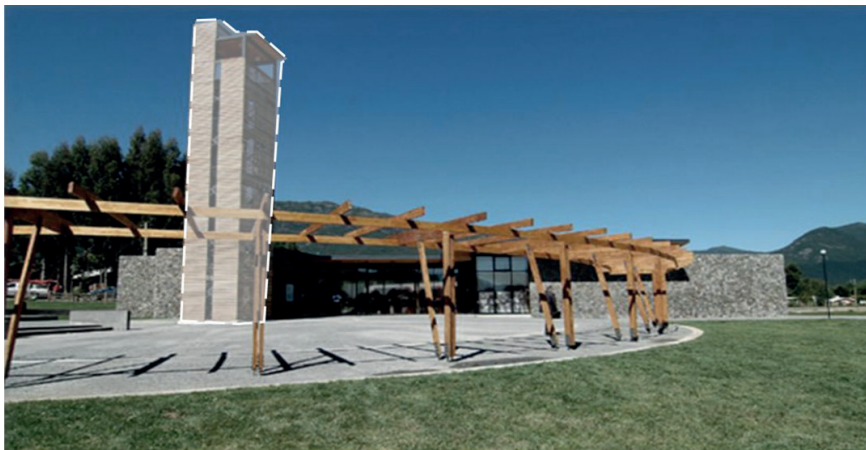
Figura 7 Acceso principal del edificio público del Museo Pehuenche.
