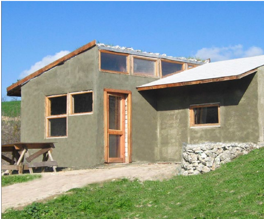
Figura 2. Casa diseñada con tecnologías sustentables y construida con materiales reciclables por estudiantes de Arquitectura y del Lyle Center for Regenerative Studies para Tijuana, México. Fuente: Pablo La Roche.
