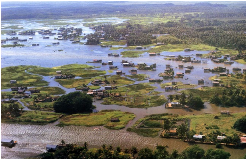
Figura 1. Vista de las edificaciones Paraujanas en Sinamaica. Fuente: Laura Rodríguez.
