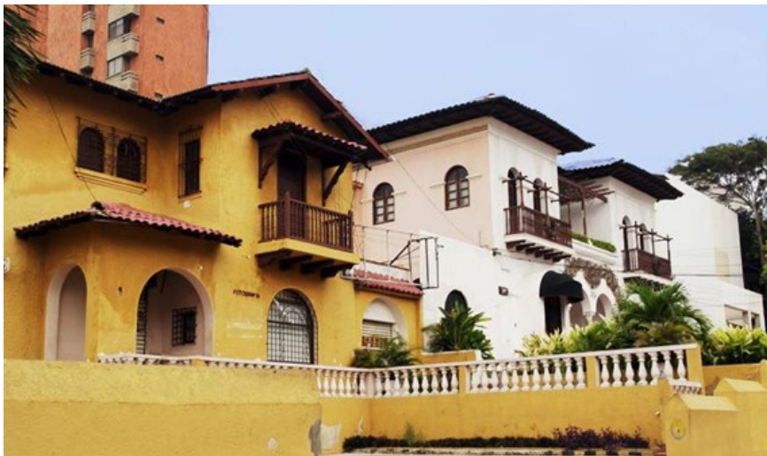
Figura 6. Fotografía de Inmuebles originalmente residenciales y actualmente adaptadas a uso comercial en el barrio Alto Prado. Fuente: www.revistas.elheraldo.co
