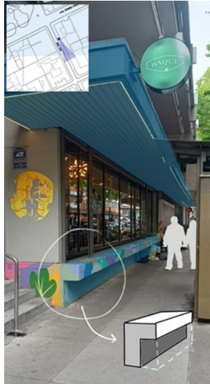
Figura 11. Esquema de alero que brinda protección climática.
