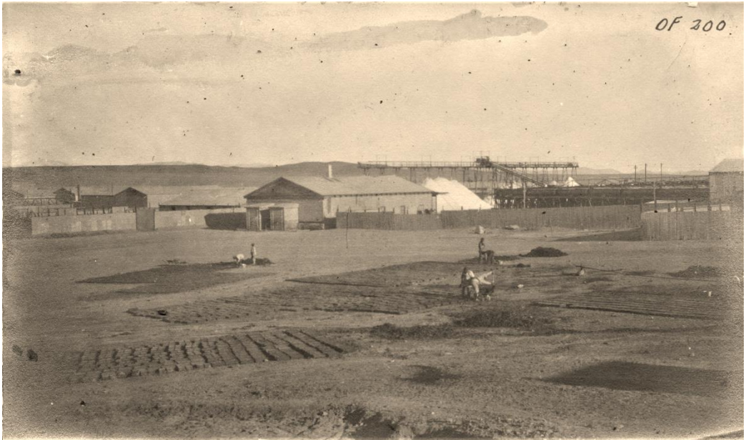
Fotografía 9. "Making adobes from ripois for use in building camp-houses". Fabricación de adobes para viviendas de obreros. Taltal, C. 1911. Hagley Museum & Library, Wilmington, Delaware.
