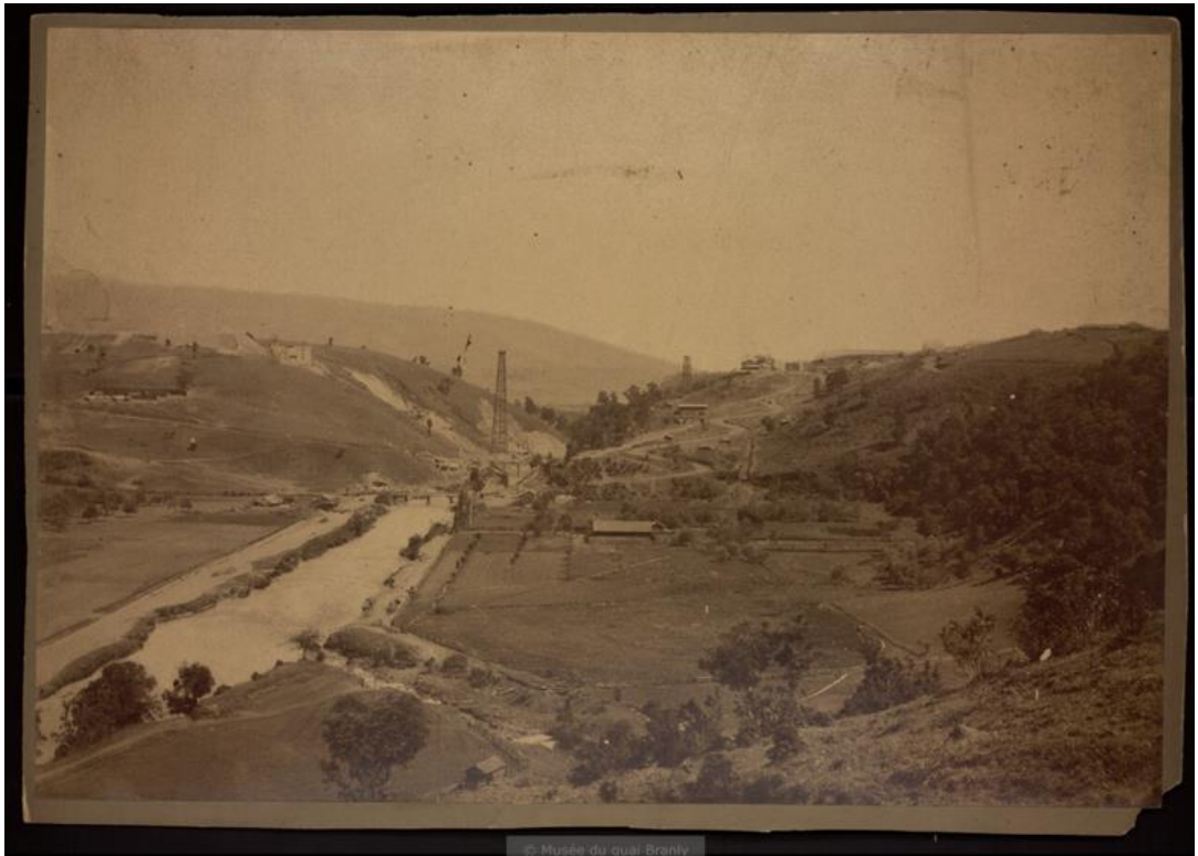
Imagen 5. Gustavo Milet Ramírez, “Construction du Pont sur le rio Malleco à Collipulli, Musée du quai Branly, Fonds Gustave Verniory, Photographies, Número de Inventario PP0194270.
