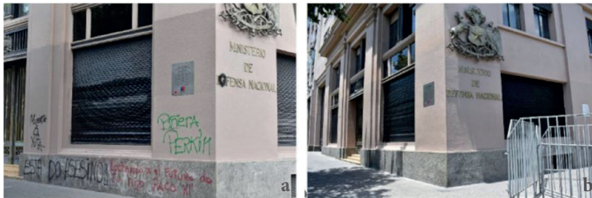
Figura 8. Ministerio de Defensa Nacional. a) Intervención al nombre del Ministerio y b) Repintado de la fachada. Archivo Personal (24-11-2019 y 29-12-2019, respectivamente).
