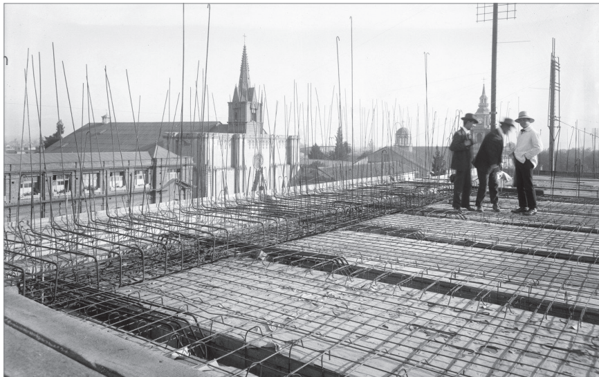
Figura 8. Armadura de una losa de hormigón de la Biblioteca Nacional en construcción.
