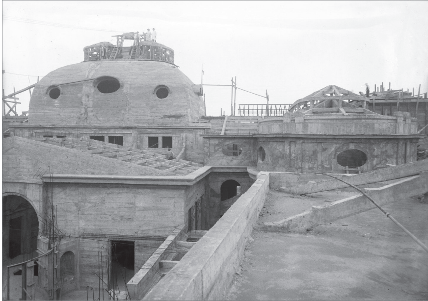
Figura 9. Obra gruesa de hormigón de la Biblioteca Nacional, c. 1919.
