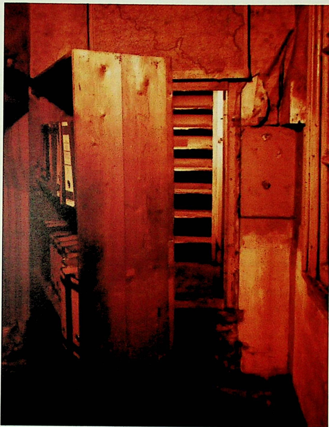
Acceso camuflado al anexo.
