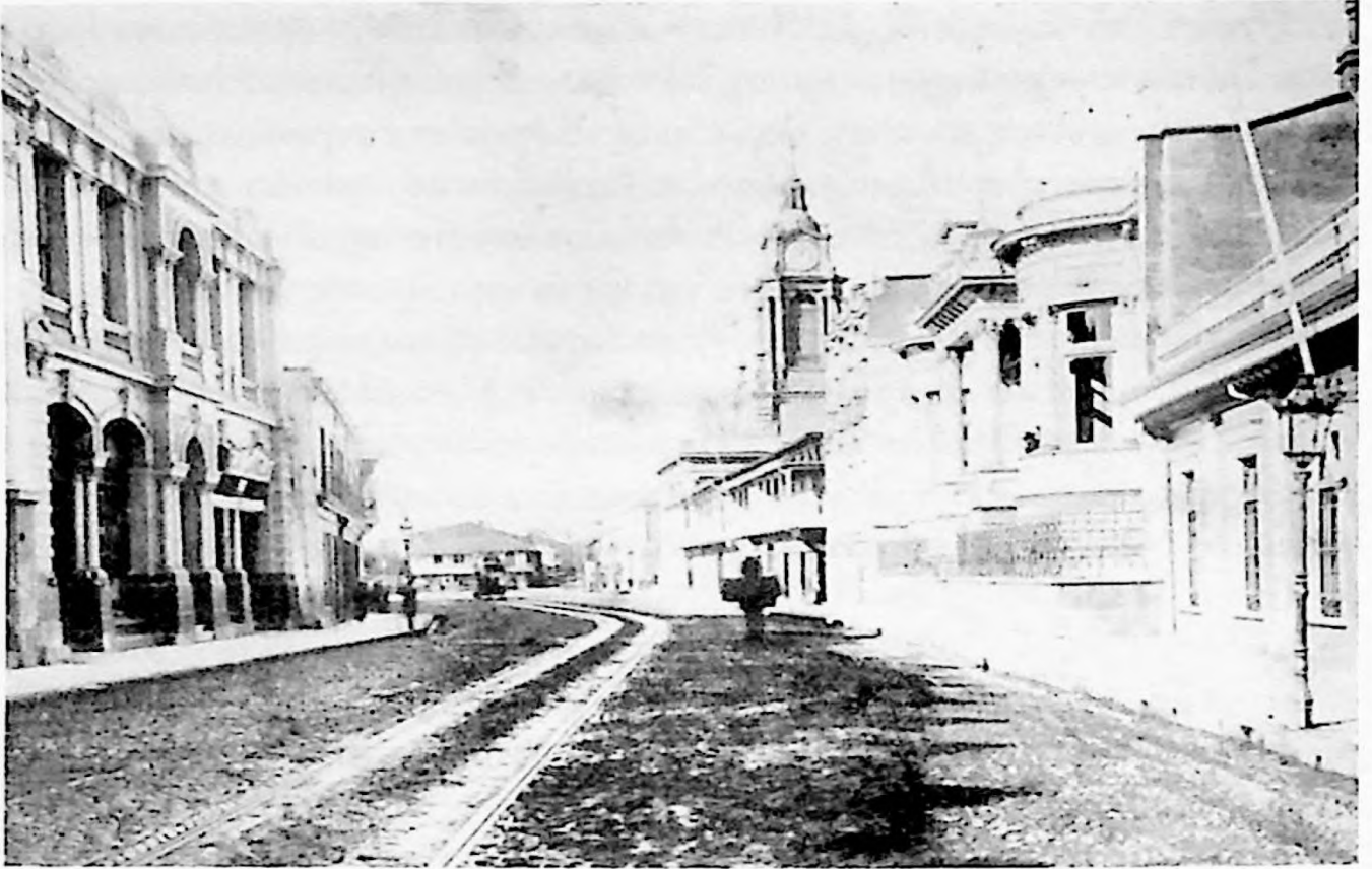
Vista de antigua calle de Valparaíso.
