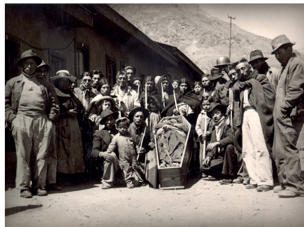
Fig. 3: Rodríguez, S. Sepelio campamento del Ferrocarril . Fuente: PUCP - Sist. de Bibliotecas.
