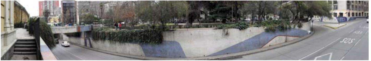
Fig. nº8: Vista panorámica del paso bajo nivel del Cerro Santa Lucía en Santiago, proyecto llevado a cabo por la CORMU y diseñado por el Grupo D.I. (Carlos Ortúzar, Eduardo Martínez Bonati e Iván Vial) en 1970. Fotografía: Rodrigo Vera.
